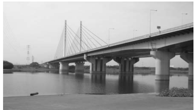
写真-1：国道 298 号「幸魂大橋」
