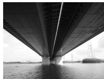
写真-2：幸魂大橋桁下状況
