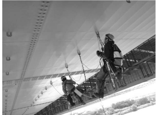
写真-2：ロープアクセスによる点検状況1（桁下：幸魂大橋）
