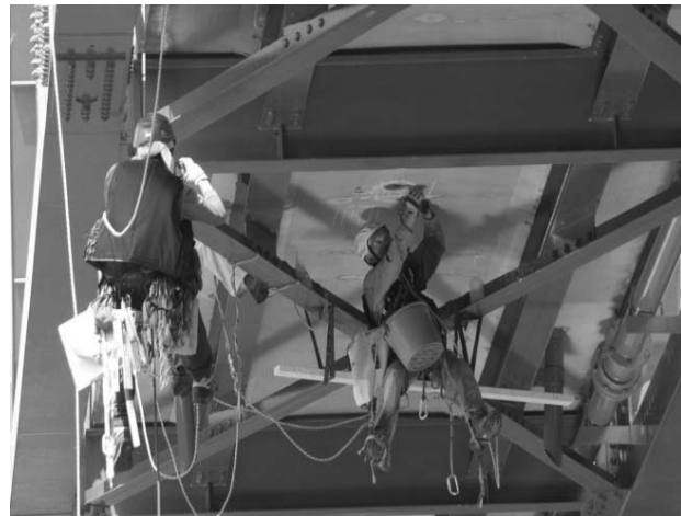
写真-3：ロープアクセスによる点検状況2（床版：他事例）
