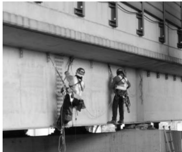
写真-4：ロープアクセスによる点検状況3（主桁：他事例）
