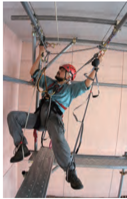
③最初のアンカーのあぶみに体重をあずけ、ショートカウズテイルを外す。
