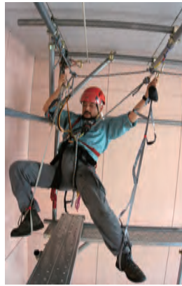
②最初のアンカーカラビナと次のアンカーカラビナにそれぞれあぶみを接続し、それぞれに足を入れて立ち上がる。
