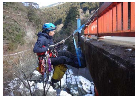
ロープガード設置状況
